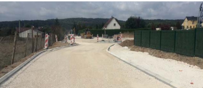
Les Champs Cerisiers en travaux
