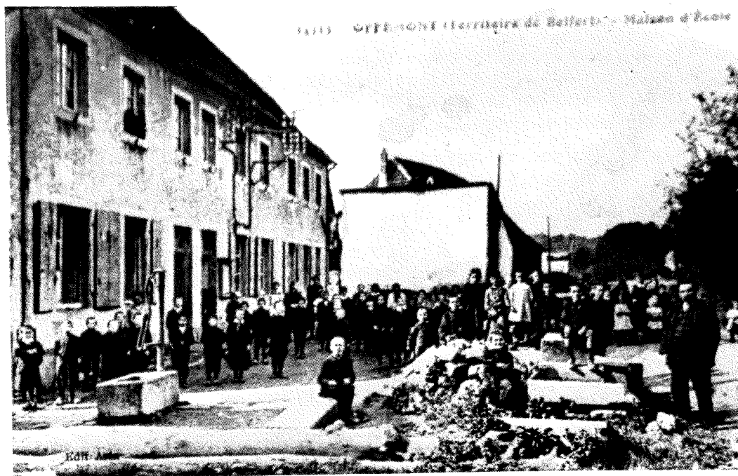
La "Maison d'Ecole" aujourd'hui école du Centre, il y a quelques dizaines d'années quand la circulation automobile ne posait pas trop de problèmes.
