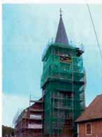
hydro gommage des pierres et réfection des joints. La présence d'imposants échafaudages a permis de changer quelques éléments de zinguerie. L'appendice
